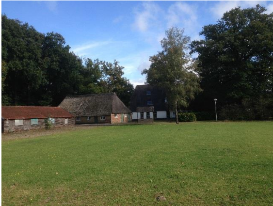
Figuur 8. Bestaande (Oude) boerderij
